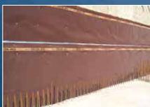
DELTA-MS Saubereitsschicht, Grundmauerschutz, Sickerschicht
