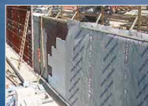
DELTA-TERRAXX TP Druckbeständige Noppenbahn mit hoher Drainagekapazität
